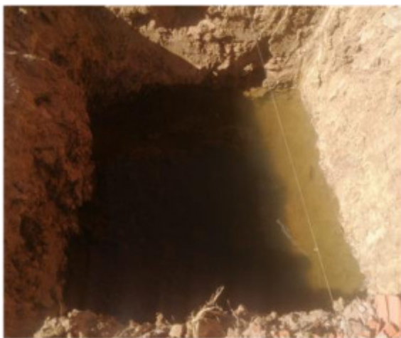
OBRA DE CAPTACION DE AGUA
