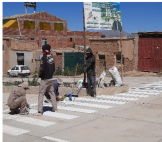
DEMARCACION DE SEÑALIZACION HORIZONTAL
