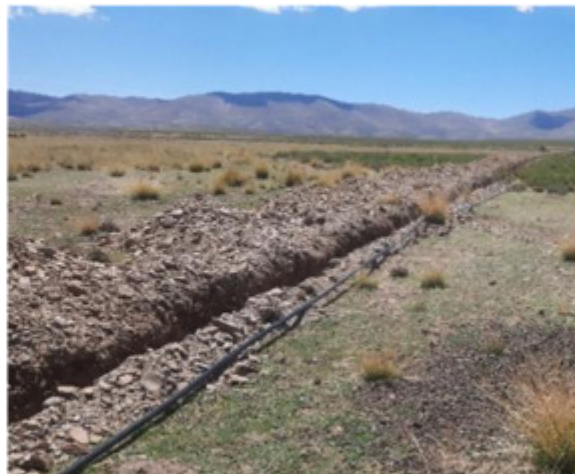
TENDIDO DE TUBERIA
