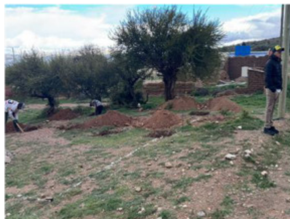
Item Excavacion de suelo
