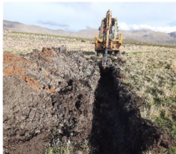
TENDIDO DE RED PRINCIPAL
