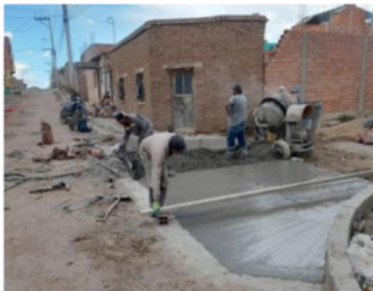
VACIADO DE PAVIMENTO RIGIDO
