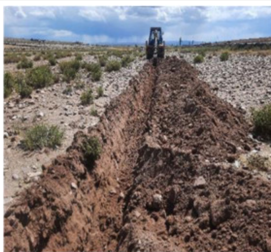
EXCAVACION DE ZANJA
