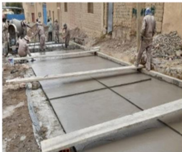
VACIADO DE PAVIMENTO RIGIDO
