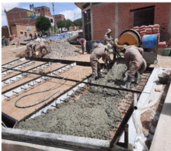
VACIADO DE PAVIMENTO RIGIDO
