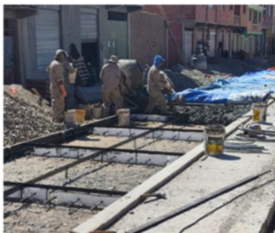
VACIADO DE PAVIMENTO RIGIDO
