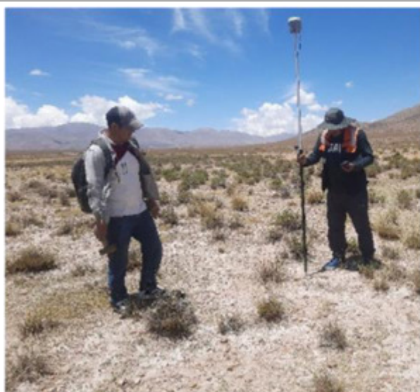
EXCAVACION DE RED DE ALC
