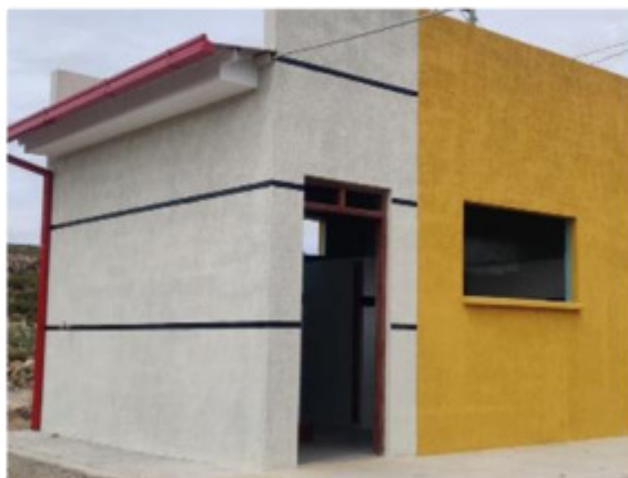
EXTERIOR BATERIA DE BAÑOS
