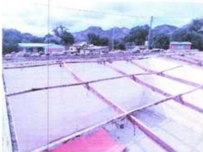
ÍTEM. Retiro de cubierta de estructura cubierta de madera
