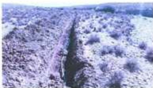
Excavación de la zanja de conducción con la retroexcavadora del GAM Villazón
